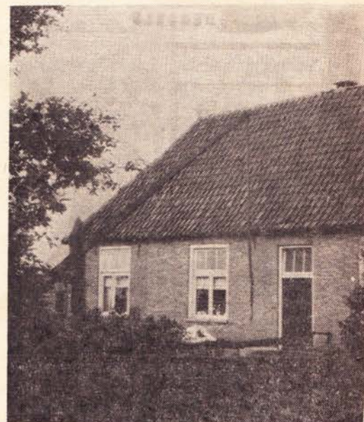
„Binnengait“ - de voormalige schippersherberg aan de Regge.
